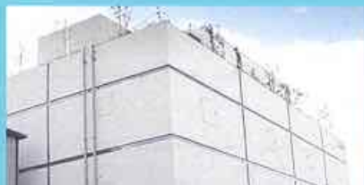
ビーエスエーロジスティックキューブ2
